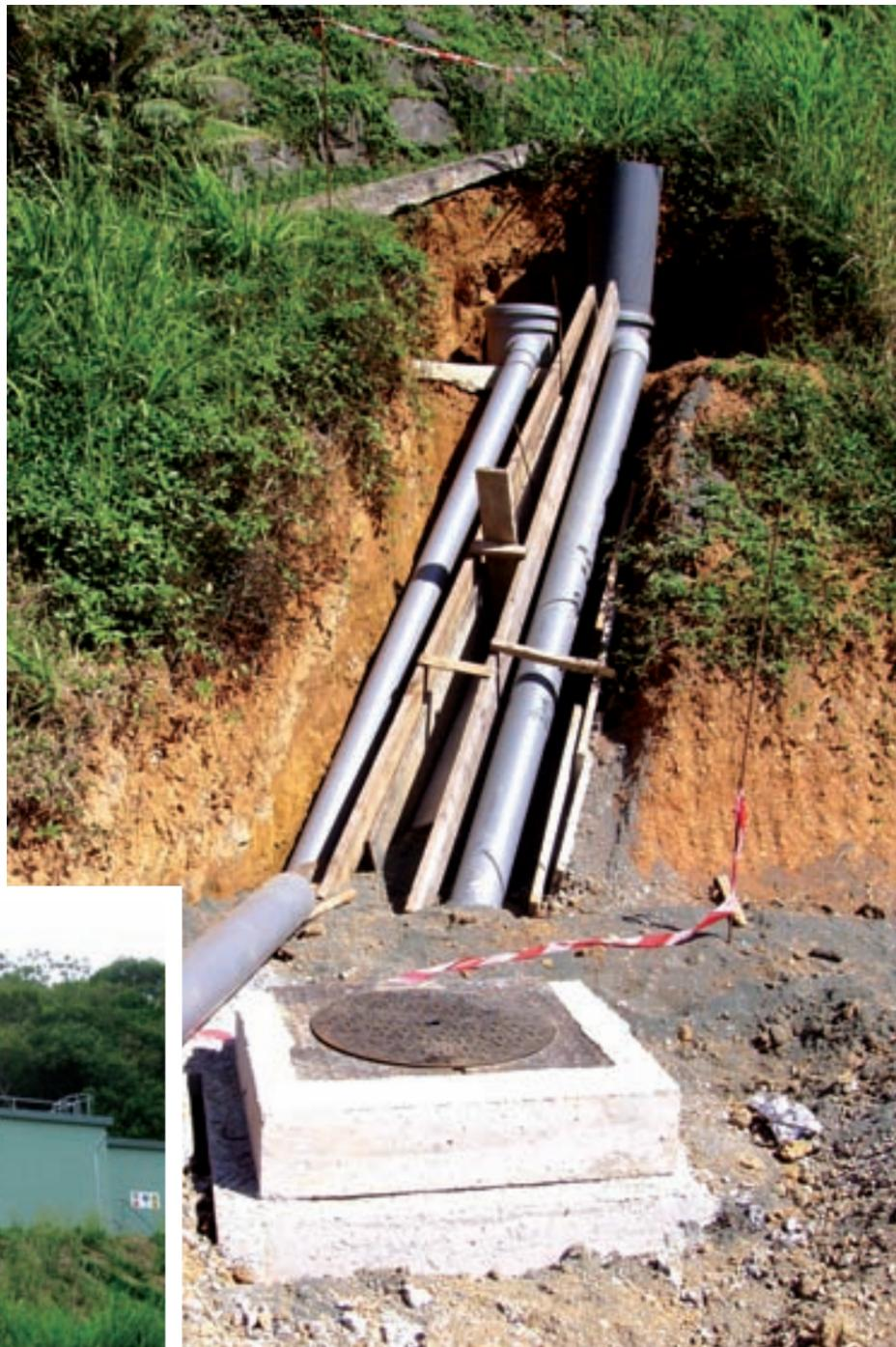
Travaux de raccordement au lotissement Giozzi des réseaux d'assainissement des eaux pluviales et des eaux usées..
