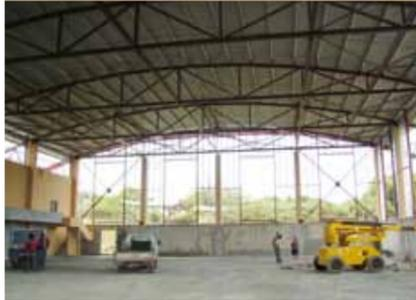
• **Salle omnisports de Koutio** : la charpente est en cours de finition. Les travaux de second œuvre vont débiter. La livraison de l'équipement est prévue en février.
